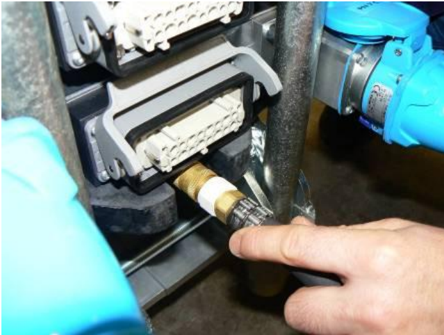
Проверить вытягиванием плотность соединения.
