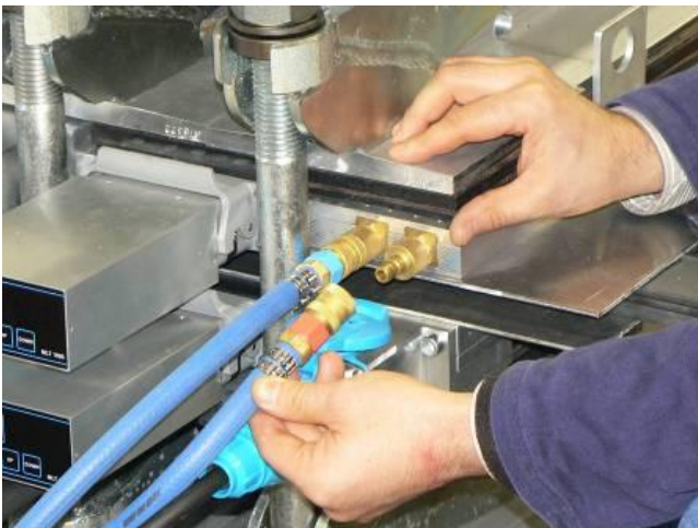
Шланги с синим кольцом - для холодной воды (исходят от насоса).
