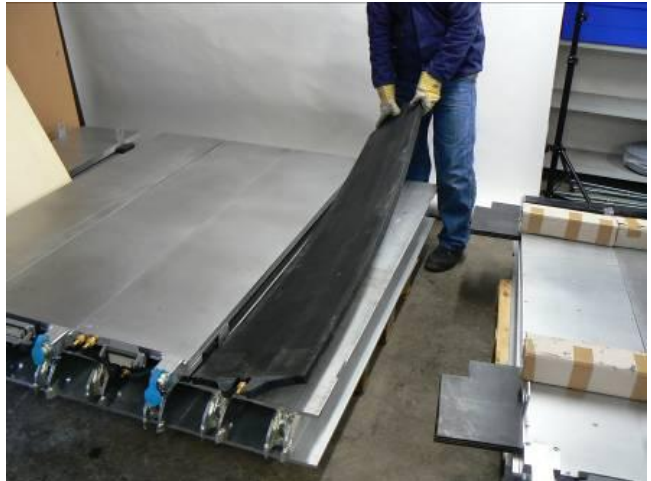
Waterbag-подушки давления положить на траверсы.
