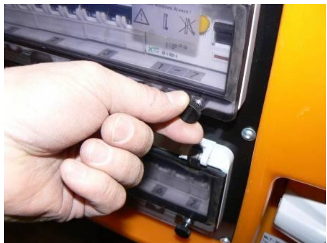
Включить защитный выключатель и закрыть окно.
